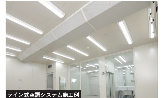
ライン式空調システム施工例
