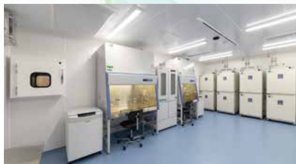
実用新案登録のFFU式空調システムと個別空調を組み合わせたハイブリットCPC施設
