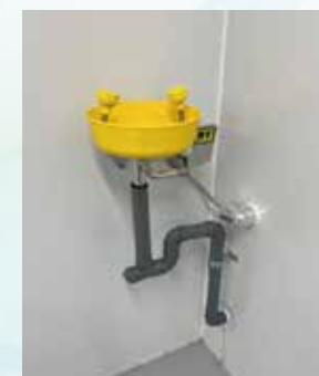
CAPの要求事項に従い、各部屋に緊急洗眼を設置
