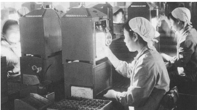
検査員による目視検査の様子（1961年）
