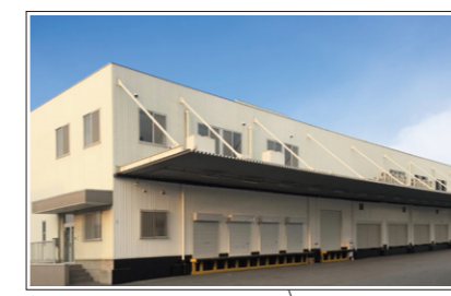
分取装置製造施設 伏見事業所(京都府)
