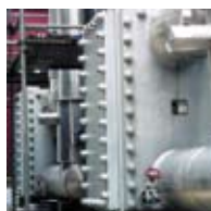
縦置き Compabloc (液一液熱回収用)
