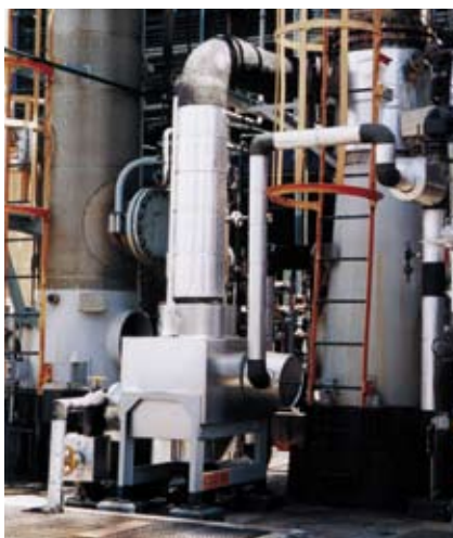
ブラジル Rhodia 社の酢酸エチル工場に設置されたストリップング塔用 Compabloc リボイラー
