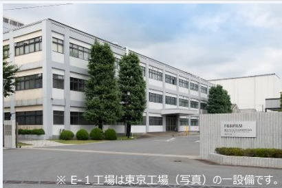
東京E-1工場 (埼玉県川越市)
